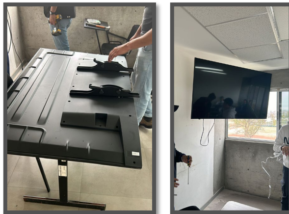
Figura 165. Reparación y mantenimiento de las pantallas ubicadas en las aulas
