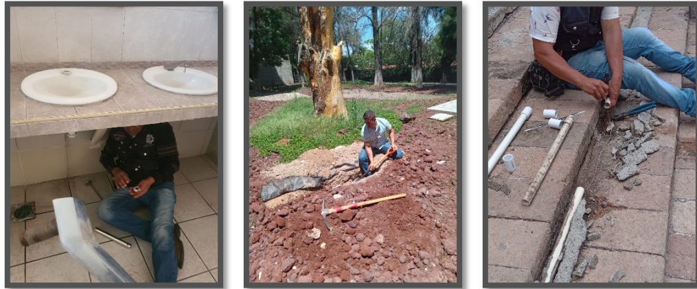
Figura 162. Mantenimiento a los baños de la unidad académica
