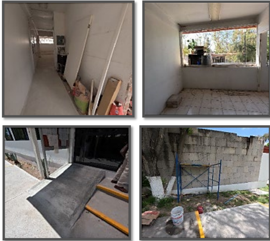
Figura 161. Rehabilitación de laboratorio de redes de la academia de sistemas y computación
