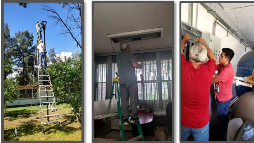
Figura 163. Instalación y cambio de luminarias
